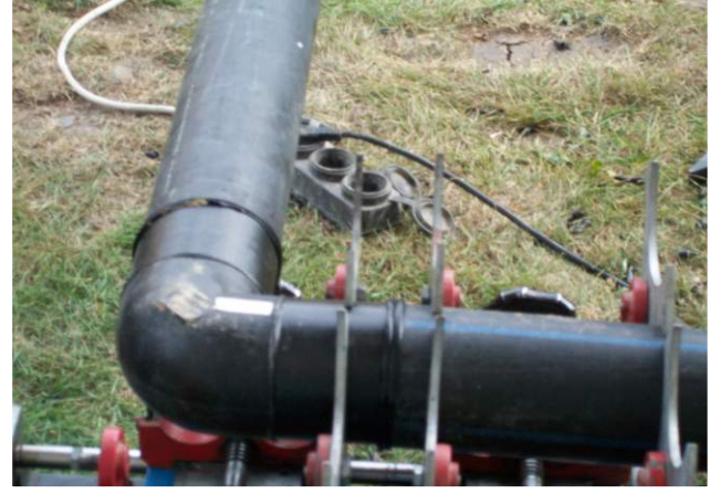
160mm HDPE 100 boru Elektrofüzyon Kaynak İşçiliği
