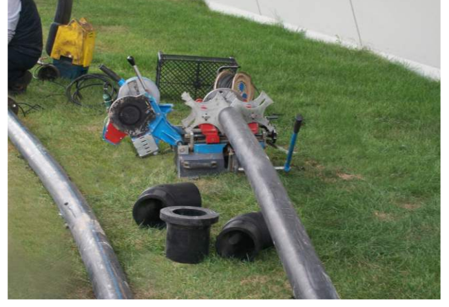
160mm HDPE 100 boru Elektrofüzyon Kaynak İşçiliği
