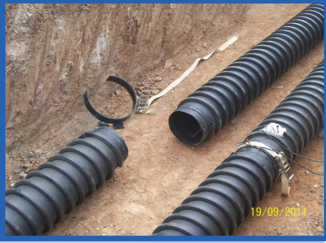
Ø500 mm ve Ø600 mm Elektrofüzyon Kaynaklı Korumalı Sarmal Boru İşçiliği
