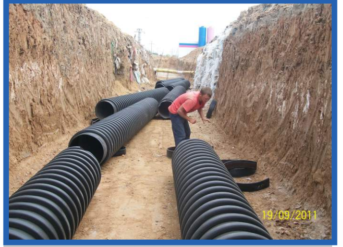
Ø500 mm ve Ø600 mm Elektrofüzyon Kaynaklı Korumalı Sarmal Boru İşçiliği
