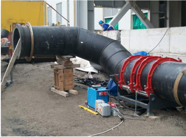
800mm Hdpe 100 Boru Alın Kaynak İşçiliği
