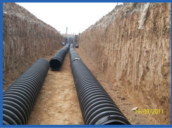
Ø500 mm ve Ø600 mm Elektrofüzyon Kaynaklı Korumalı Sarmal Boru İşçiliği
