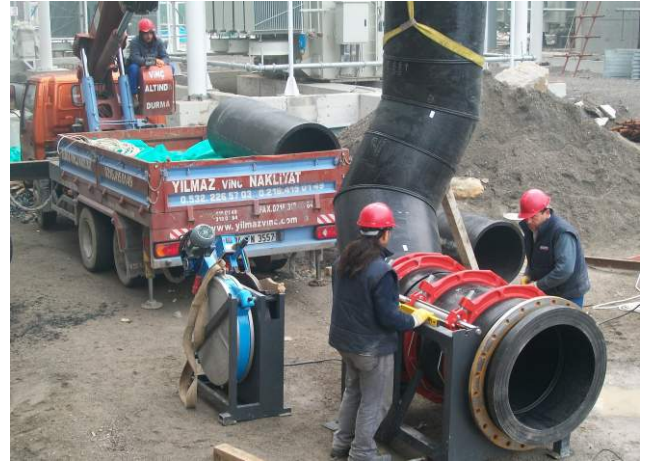
800mm Hdpe 100 Boru Alın Kaynak İşçiliği
