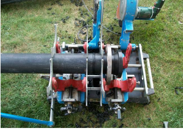
160mm HDPE 100 boru Elektrofüzyon Kaynak İşçiliği
