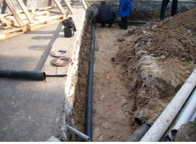
160mm HDPE 100 boru Elektrofüzyon Kaynak İşçiliği
