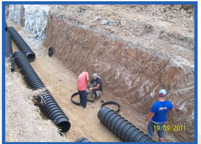
Ø500 mm ve Ø600 mm Elektrofüzyon Kaynaklı Korumalı Sarmal Boru İşçiliği
